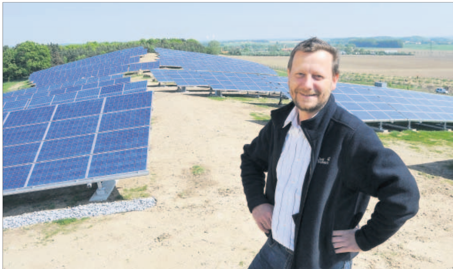
Andreas Krellmann vom Dresdner Ingenieurbüro CWH zeigt die neue Solaranlage auf der abgedeckten Mülldeponie Nadelwitz. Sie ist die mit Abstand größte Einrichtung, aus der in Bautzen Sonnenstrom erzeugt wird. Hier forschen künftig auch Wissenschaftler. Foto: SZ/Uwe Soeder
